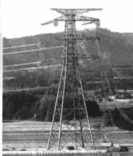
图 12-25 日本 1000kV 双回路转角钢管塔
