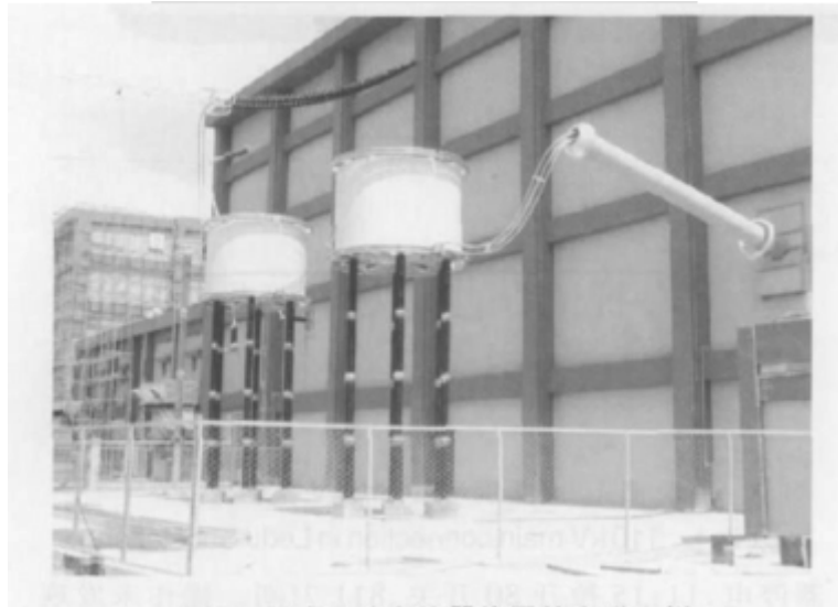
图 8-11 干式平波电抗器线圈的串联实例
